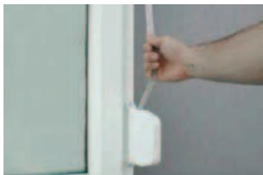
Beim **Hinaufziehen** des Rollladenpanzers wird der Gurt von oben nach unten gezogen, die Gurtaufwicklung erfolgt selbsttätig.
