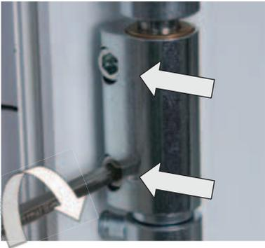
Durch Verstellen beider Schrauben am Mittelteil des Drehbandes mit Inbusschlüssel SW5 erfolgt die Seitenverstellung.
