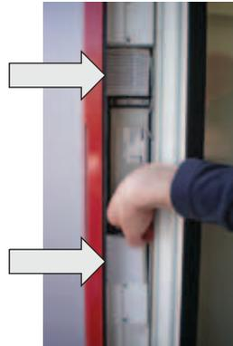
Verschmutzte Filter entfernen und neue
