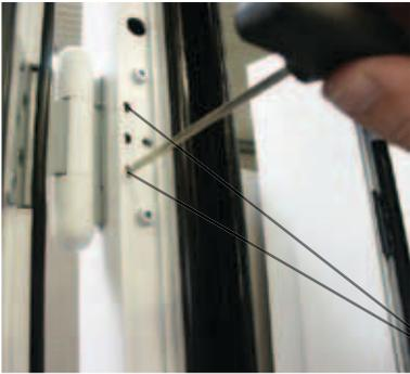
Beide Spannschrauben bis zum Anschlag lösen.
