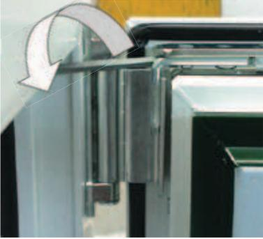
Verstellung Richtung Band- oder Geriebeseite mit Inbusschlüssel SW4.
