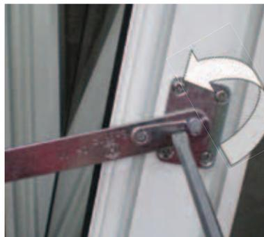
Verriegelung der Putzschere mit einem Flachsraubendreher öffnen und Putzschere aushängen.
