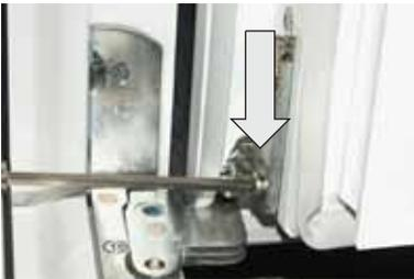
Anpressdruckverstellung mit Inbusschlüssel SW4.
