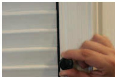
Beim **Schließen** des Ladens wird der Ladenhalter gedrückt und der Laden hereingedreht. Danach den Verschlusshebel drehen bis der Drehstangenverschluss selbsttätig einrastet.
