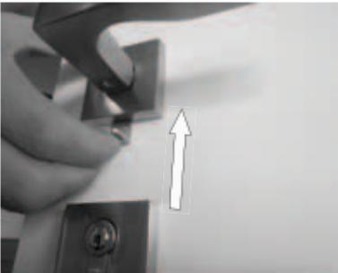
2. Spezialwerkzeug vollständig bis zum Anschlag einführen. Werkzeug rastet ein, Spannsystem wird gelöst.
