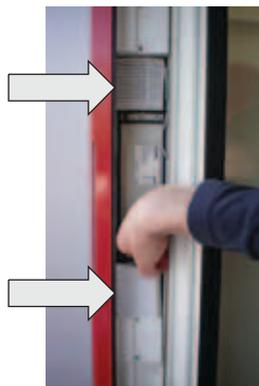
Filtermatten darüber setzen und Abdeckung wieder montieren.
